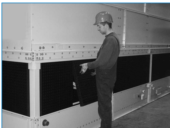
Rimuovere gli schermi d'ingresso combinati
