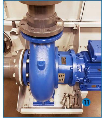
10. Ne placez pas encore les écrous pour pouvoir repositionner la pompe.
