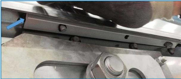
Un profil d'étanchéité installé
