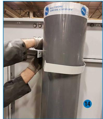
13. Installez le support de la tuyauterie de pompe. Retirez 3 goujons de la bride supérieure de la section bassin et installez le support. Utilisez le schéma 12D115 pour la position d'installation précise du support.
