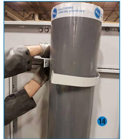
13. Instale el soporte de la tubería de la bomba. Retire los tres tornillos de la brida superior de la sección de la balsa e instale el soporte. Utilice el plano 12D115 para conocer la posición exacta de instalación del soporte.
