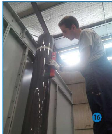
15. Los orificios de deslizamiento permiten un correcto posicionamiento y la reutilización de los tornillos existentes.
