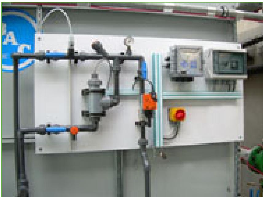
BAC présente une large gamme de **solutions de traitement automatique de l'eau** pour lutter contre la corrosion, l'entartrage, l'encrassement et la prolifération microbologique dans les systèmes de refroidissement intégrant des tours de refroidissement BAC.
