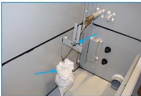
Befestigung und Umhüllung der Schwimmerkugel
