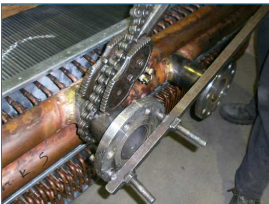
Installeren van schroefflens
