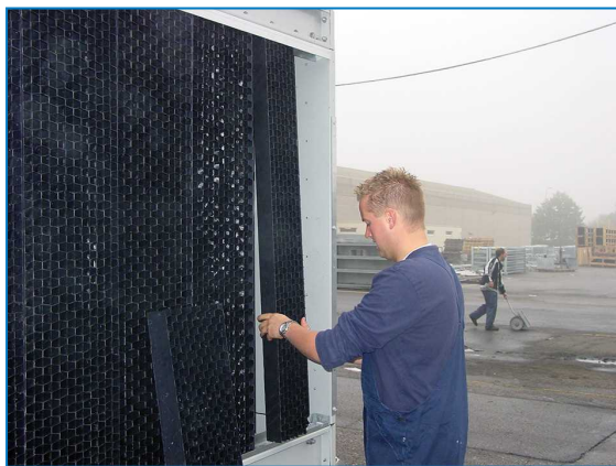
Démontage des déflecteurs d'entrée d'air
