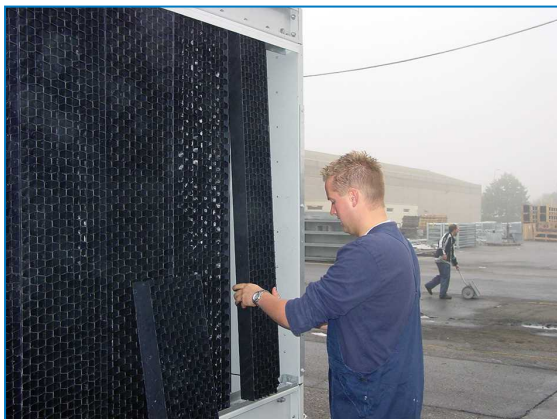
Demontáž kombinovaných krytů sání vzduchu
