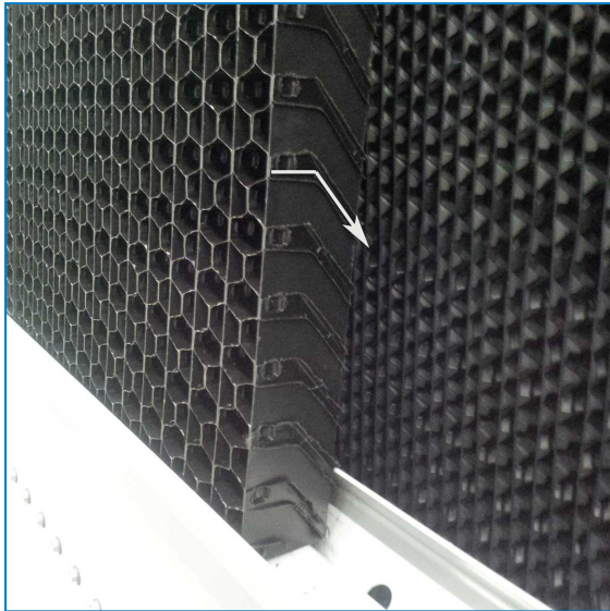
Ориентация комбинированных экранов на входе
