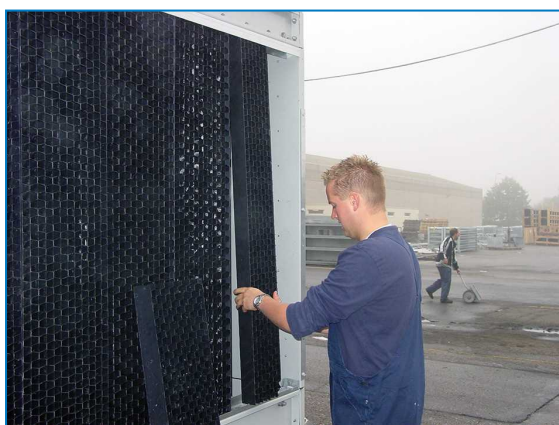
Снятие комбинированных щитов на входе
