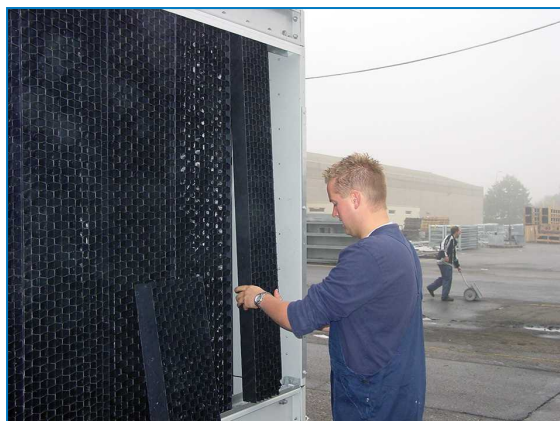
Снятие комбинированных щитов на входе
