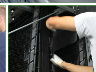
Gepatenteerd BACross-vulpakket voor eenvoudige inspectie en reiniging
